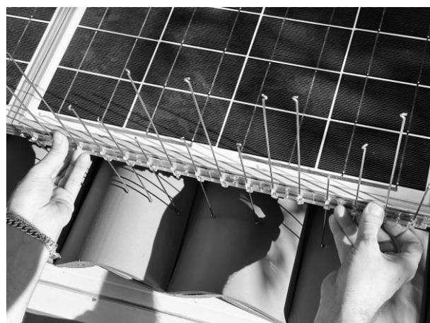
**¡Nota!** Los segmentos filiformes comenzarán a descender de forma autónoma por efecto de la gravedad deslizándose dentro de sus propios asientos de anclaje hasta apoyarse en la cubierta subyacente de manera uniforme. En caso de que algunos segmentos no desciendan de forma autónoma, realice una ligera presión con las manos en la parte superior de los mismos filamentos hasta que alcancen su final de carrera cerca de la cubierta (ver ejemplo a continuación)
