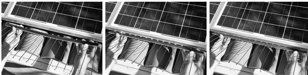
**¡Nota!** En esta fase, tenga cuidado de mantener la cinta adhesiva o la silicona distanciada del marco del panel fotovoltaico para evitar el efecto "despegar-pegar" que dañaría la eficacia del adhesivo.
