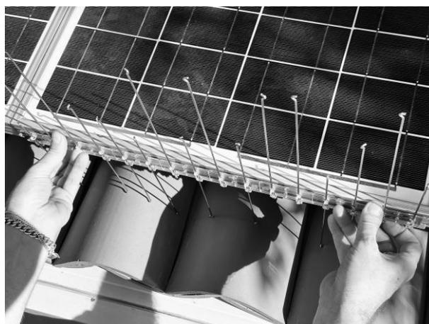
**Veillez noter !** Les segments filiformes commenceront à descendre de manière autonome par effet de gravité en glissant à l'intérieur de leurs sièges d'ancrage jusqu'à ce qu'ils s'appuient uniformément sur la couverture sous-jacente. Dans le cas où certains segments ne devraient pas descendre de manière autonome, exercer une légère pression avec les mains sur le sommet des mêmes filaments jusqu'à ce qu'ils atteignent leur fin de course à proximité de la couverture (voir exemple ci-dessous)
