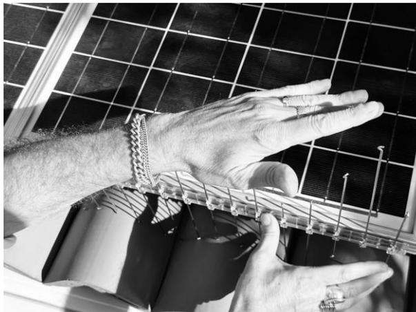
**3.7.5** Effectuer une pression uniforme avec les mains sur l'extérieur de la barrière appliquée au cadre du panneau photovoltaïque en appuyant sur la barrière sur toute sa longueur. (voir exemple ci-dessous)
